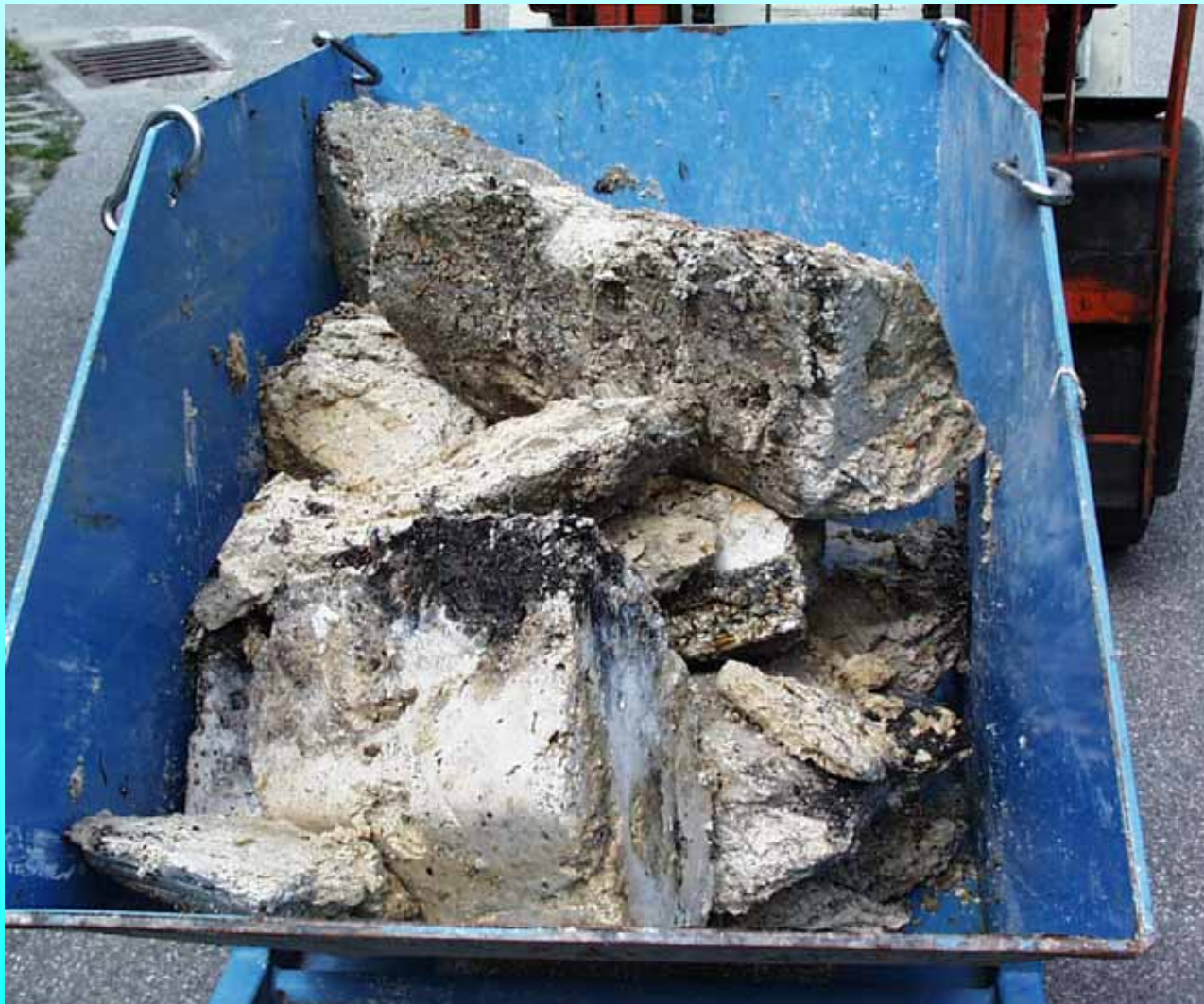
Fettstöcke beim Ablasswehr im Fettfang
