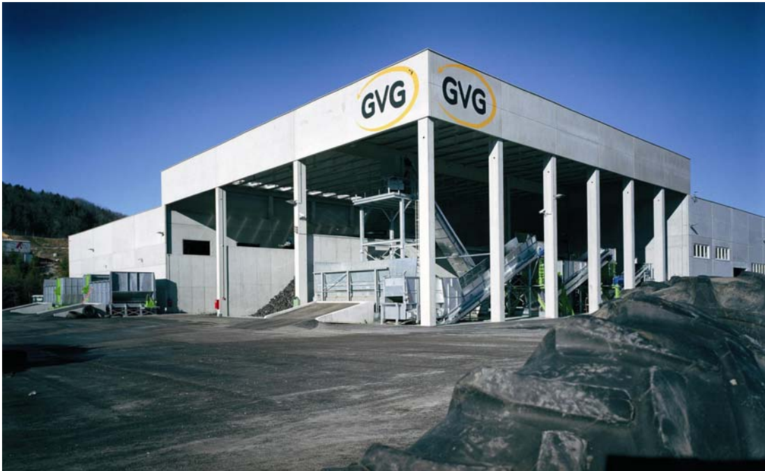
Abb.3.: Blick auf den Annahmebereich und die Vorzerkleinerung (GVG, 2002)
