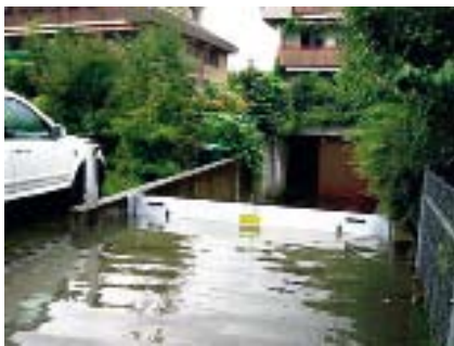
Transportable Barrieren können im Notfall innerhalb von wenigen Minuten installiert werden und bieten sicheren Schutz. Im Keller besteht aber auch Gefahr durch Wassereintritt von unten.
