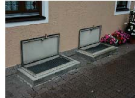
Abb. 5.6: Kellerlichtschat aus Beton, der mittels Stahlbedeckung mit Gummidichtung rasch wasserdicht verschlossen werden kann; aus [9]
