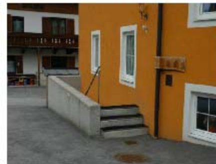
Abb. 5.7: Mittels Stufenpodest über das Hochwasserniveau gezogener Kellerabgang mit Stahlbetonschutzmauer; gegen Feststoffanprall ungeschütztes Fenster auf Straßenniveau; aus [9]
