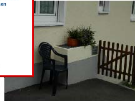
Abb. 5.5: Druckwasserdicht mit der Wand verbundener, nach unten geschlossener Kellerfensterlichtschat aus Beton, der deutlich über das Hochwasserniveau hochgezogen wurde; aus [9]
