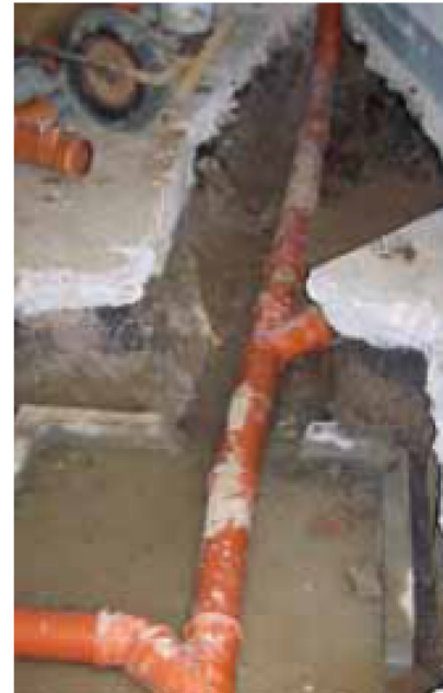
Erneuerung in offener Bauweise
